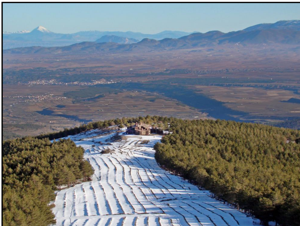
1. El Refugio Postero Alto, en el cortafuegos de la Loma de Enmedio, con vistas al N.
