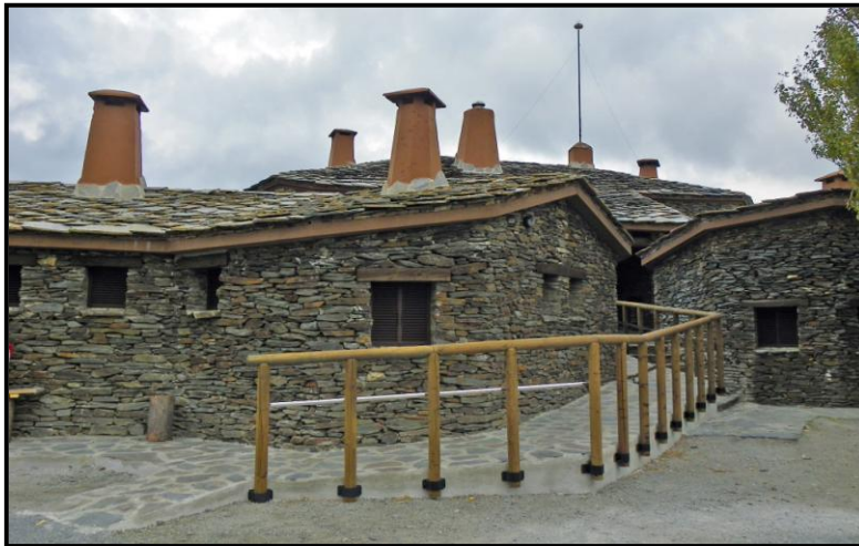
4. Actualmente libre de barreras arquitectónicas.
